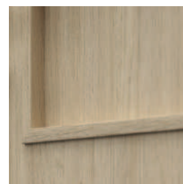
rámik s panelom, POZNÁMKA: v prípade laminátu CPL je rámik zaoblený
